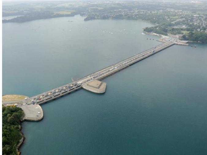
L'usine bretonne de la Rance est la seule centrale au monde qui convertit la force des marées en électricité. Sa production peut alimenter toute l'année une ville comme Rennes. La particularité technique de type d'usine est que les turbines peuvent fonctionner dans les deux sens.
